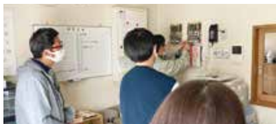
自動火災報知器・ケアコールシステム
